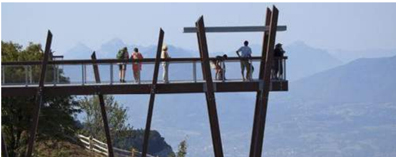
Belvédère du Revard (73) - Epode Aménagements
