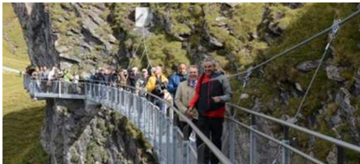
Passerelle en encorbellement « Fist Cliff Walk by Tissot » - Gindenwald (Suisse)
