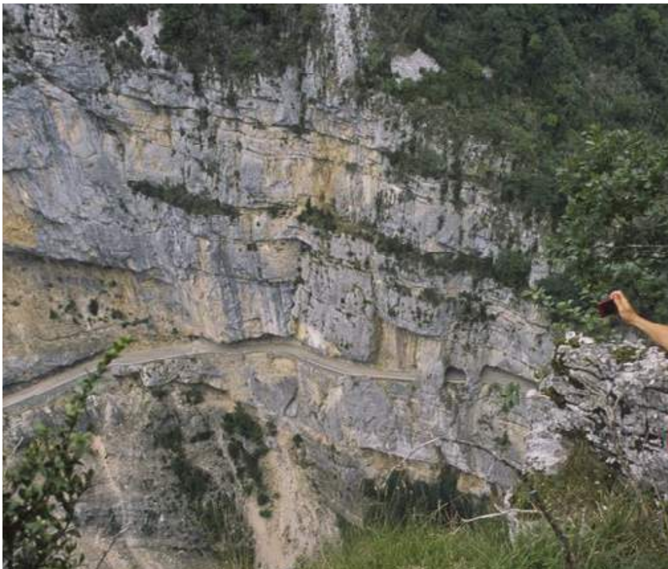
Vue sur l'ancienne route depuis l'ancien chemin des goulets en rive gauche.
