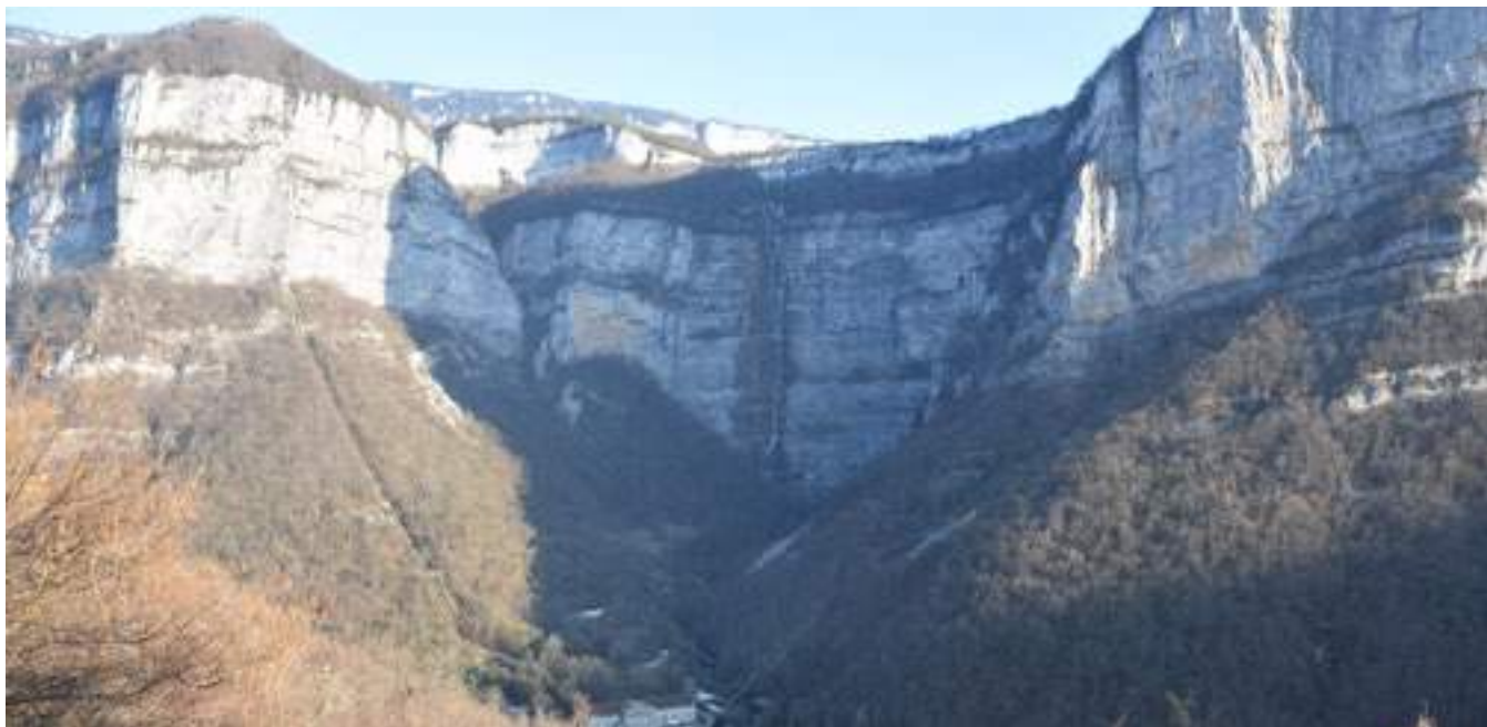
Vue sur le cirque et la centrale électrique
