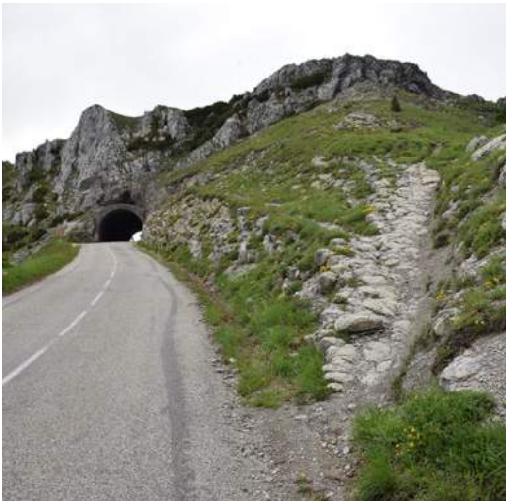
Départ empierré du chemin depuis la route qui conduit aux Rochers de la Sausse. Au loin, le tunnel parfaitement inséré dans la roche, et, au dessus, le site de contemplation dont la forme répond à celle de l'infrastructure.
