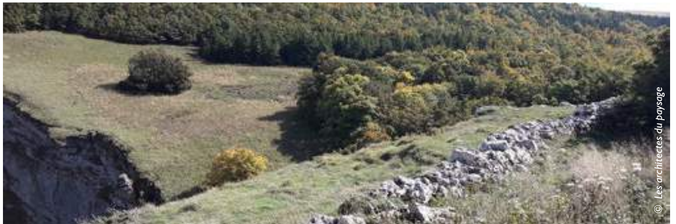
Le mur des Chartreux au belvédère de l'Aubasse
